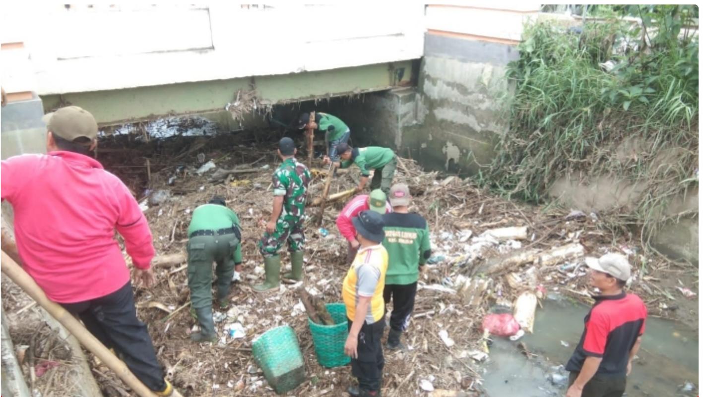
(Foto istimewa) Gotong Royong Pembersihan Aliran Sungai
